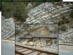
Glissement de terrain
