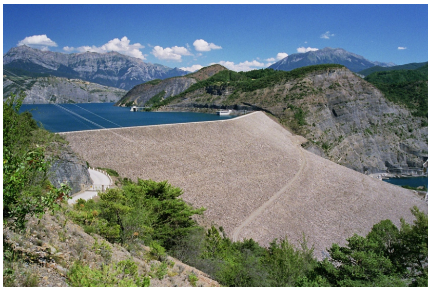
Barrage de Serre-Ponçon © EDF
