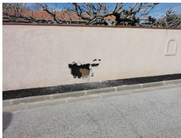
Illustration 4: Création volontaire d'une ouverture pour évacuer les eaux - La Londe-Les-Maures
