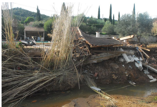
Illustration 5: Destruction totale d'une construction annexe à Notre Dame des Maures (commune de La Londe-Les-Maures)
