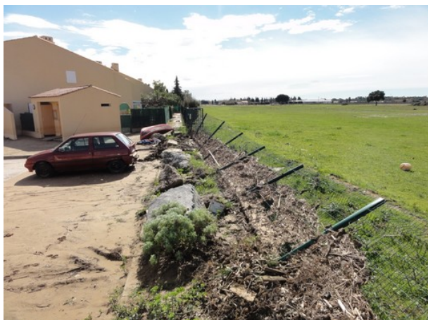
Illustration 1: Clôture renversée à La Londe-Les-Maures par manque de transparence
