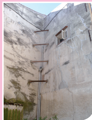
Ensemble de bâtiments fissurés, affectés par un affaissement lié à de la dissolution de gypse, à Bargemon (Var - 83) © BRGM
