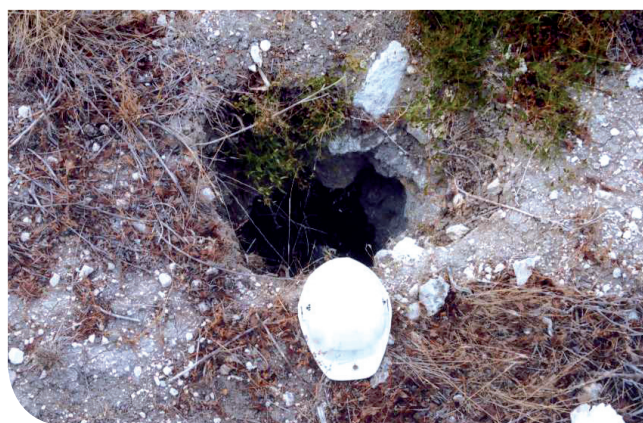
Indices d'effondrements sur le site des anciennes carrières de gypse de Saint-Pierre-les-Martigues (Bouches-du-Rhône - 13) © BRGM
