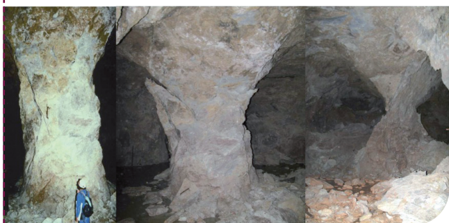
Anciennes carrières de gypse à Roquevaire (Bouches-du-Rhône - 13) © INERIS
