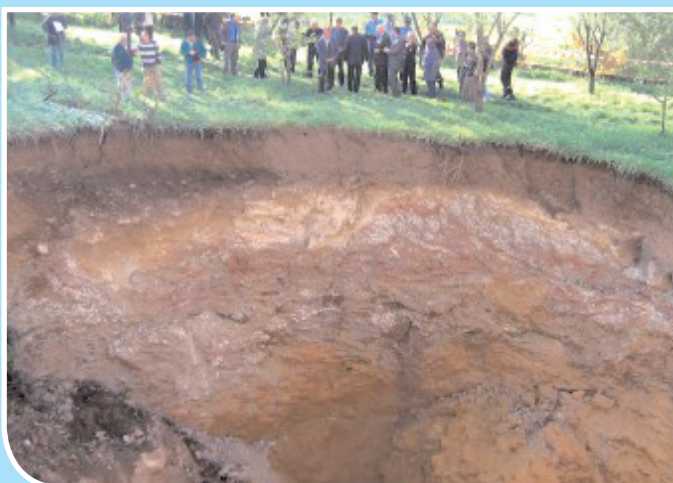
Un des derniers effondrements sur Roquevaire le 24 octobre 2005 (Bouches-du-Rhône - 13) © INERIS
