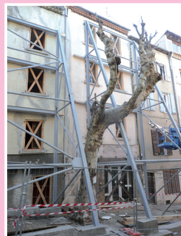
Ensemble de bâtiments fissurés, affectés par un affaissement lié à de la dissolution de gypse, à Bargemon (Var - 83) © BRGM
