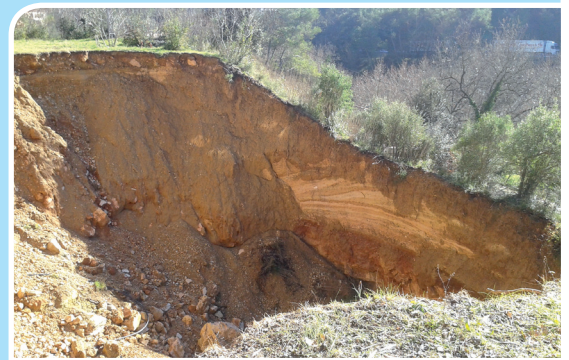
Effondrement du Luc-en-Provence – (Var – 83) © BRGM
