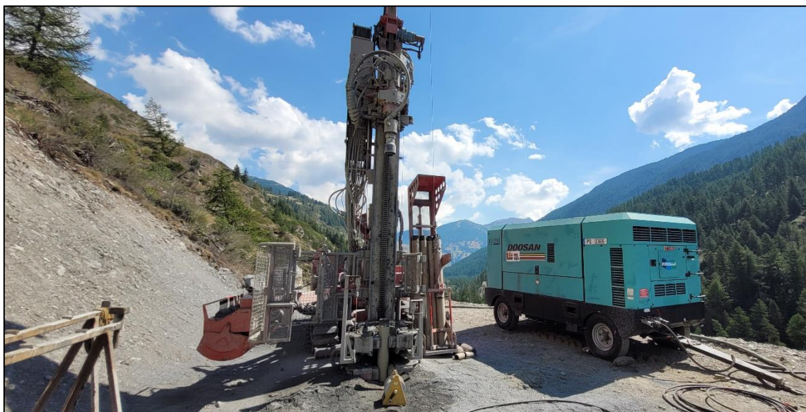
Photographie du chantier
