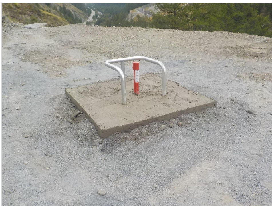
Photographie de l'ouvrage réalisé
