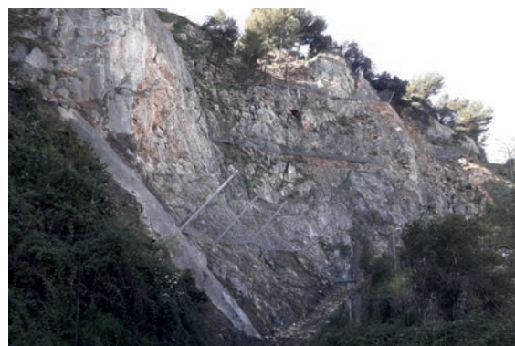
Falaise après confortement
