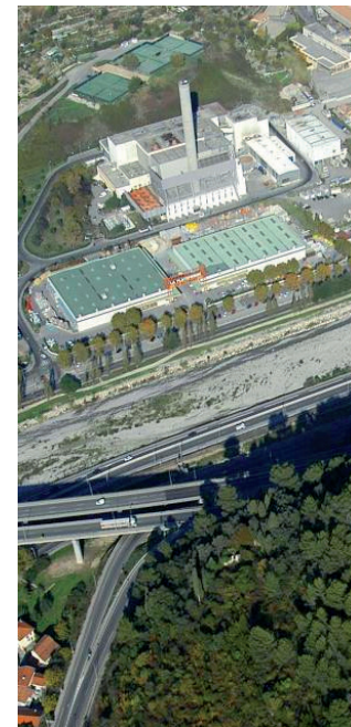
Usine d'incinération - NCA Source : Ville de Nice
