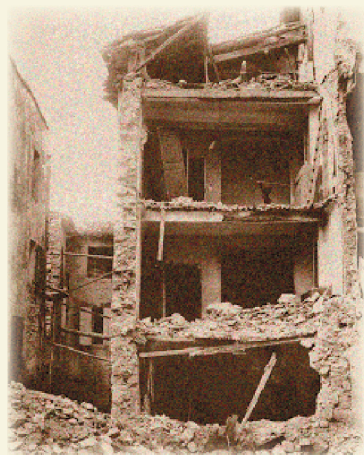
Dégâts à Saint-Cannat.
